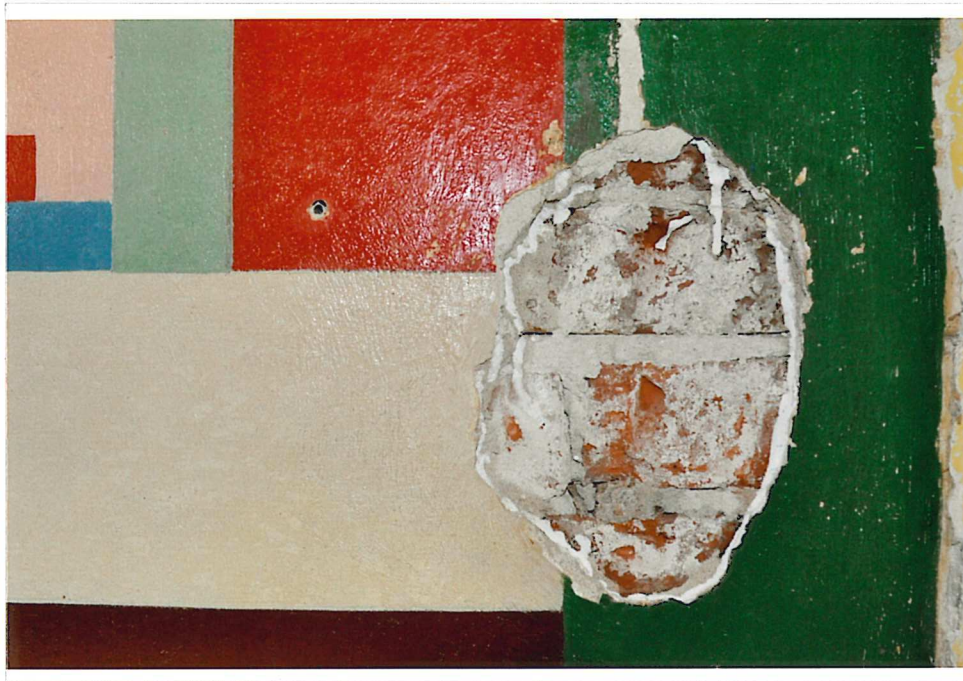
042 Detailaufnahme – Entnahme der Zementputzergänzung und Randfixierung mit Calxnova Injektionsmörtel
