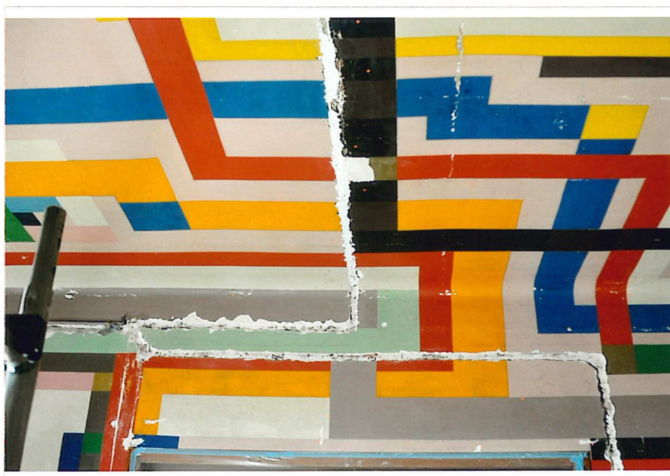
047 Detailaufnahme Westwand – Zustand nach der Entnahme der Putzergänzungen und Elektrokabel
