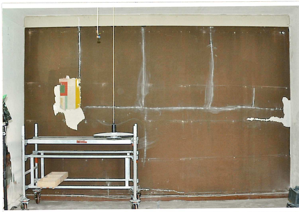
015 Zustand nach der Abnahme der Rigipswand und Vertäfelung auf der Nordwand
