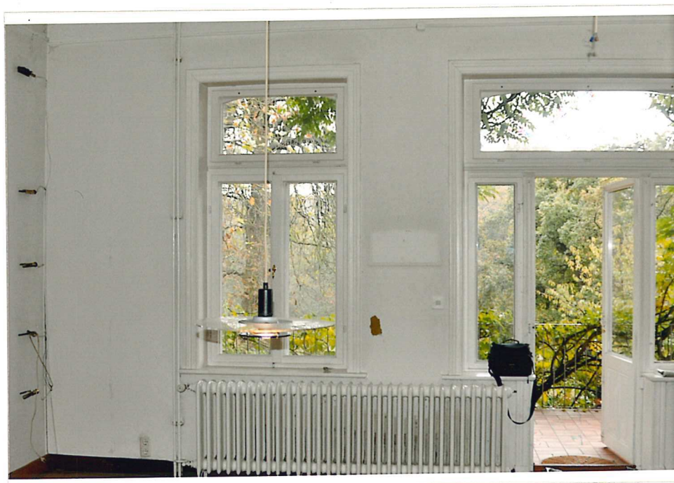
002 Vorzustandsaufnahme – Ostwand (Teil1)
