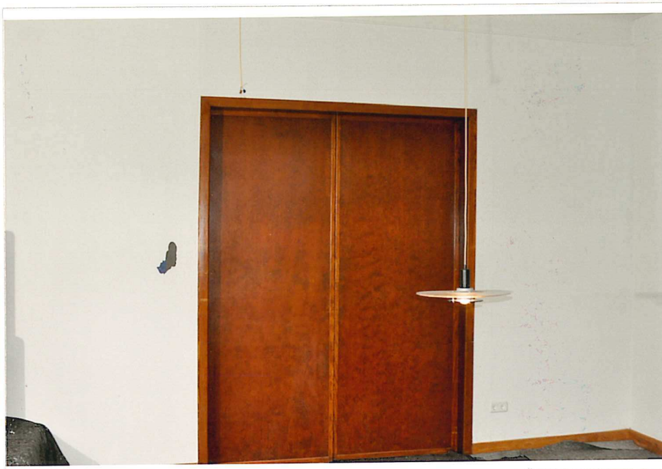
006 Vorzustandsaufnahme – Westwand (Teil2)
