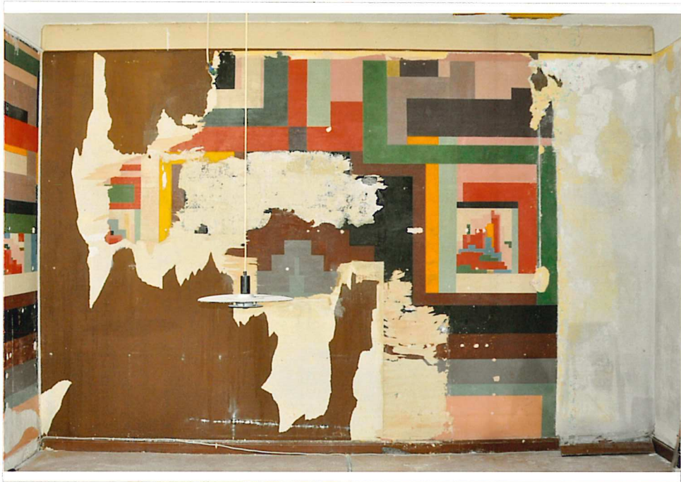
016 Zwischenzustand – während der Abnahme der Tapeten und Farbanstriche
