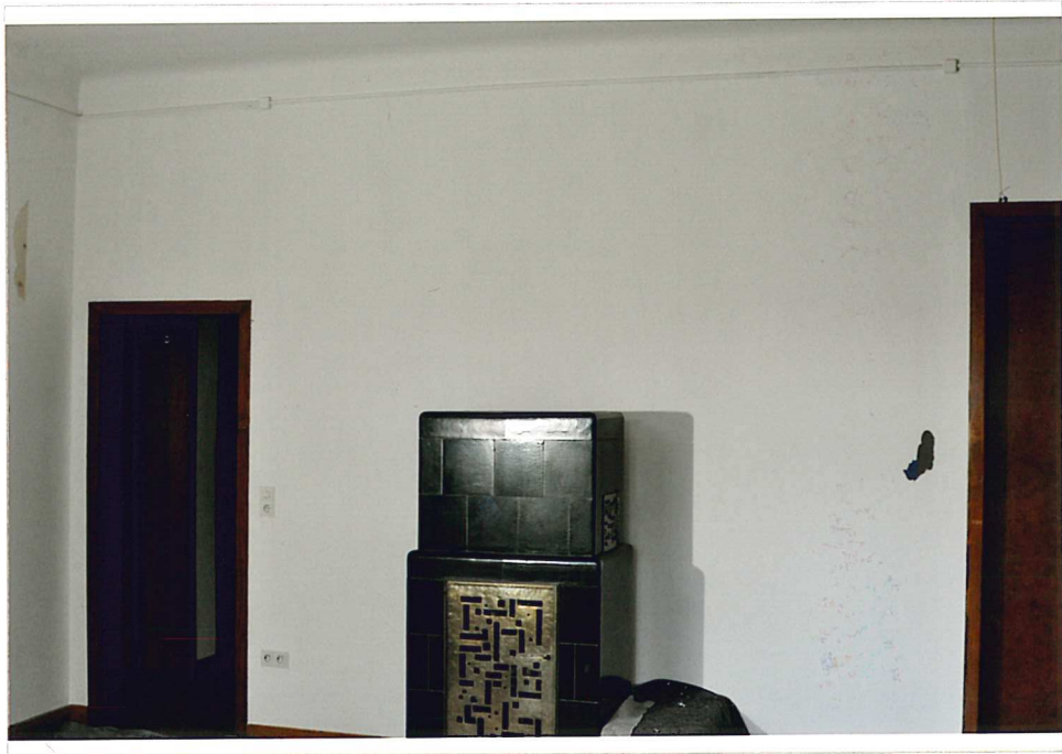
005 Vorzustandsaufnahme – Westwand (Teil1)
