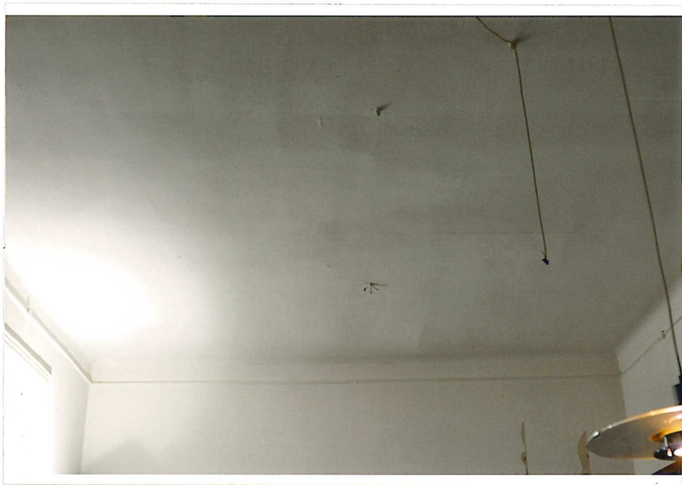
007 Vorzustandsaufnahme – Decke (Süd)
