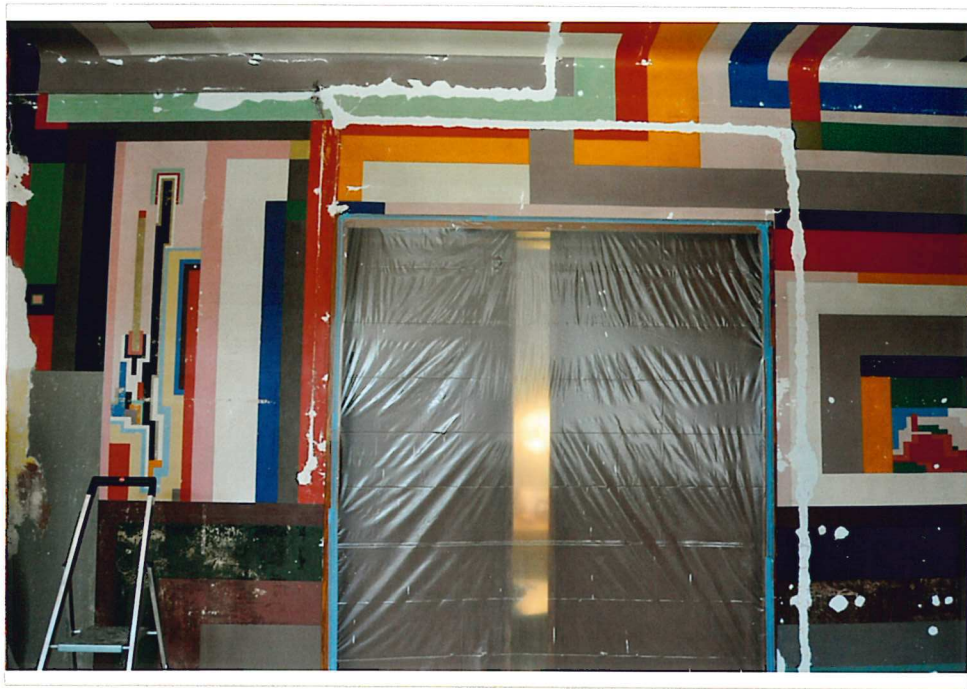
050 Ansicht Westwand mit neuen Kalkputzergänzungen, grundiert
