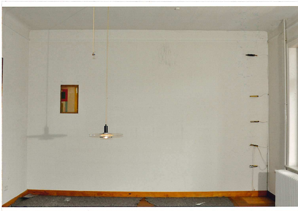
014 Vorzustand – Nordwand mit Rigipsverkleidung und Holzvertäfelung bzw. diversen Tapeten und Anstrichen
