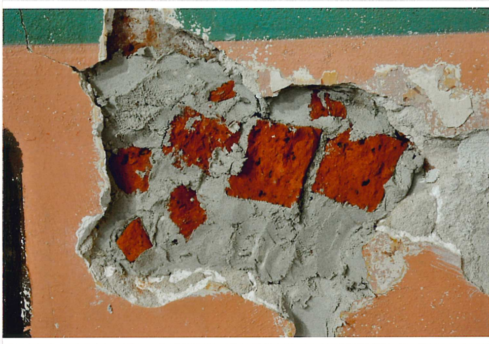
040 Detailaufnahme – Putzsicherung der Ränder mit Calxnova; Ergänzung mit Kalkmörtel und Ziegelstein
