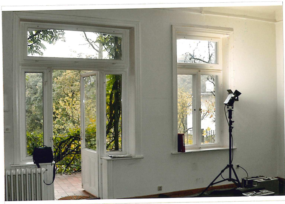
003 Vorzustandsaufnahme – Ostwand (Teil2)
