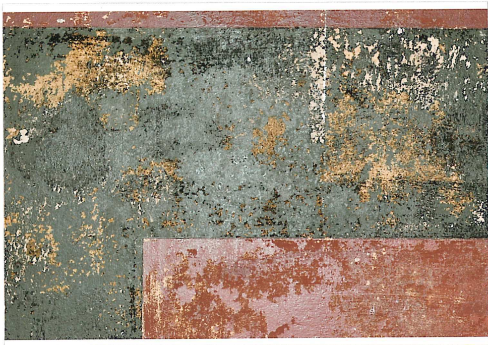
024 Schadensaufnahme – lose Malschichten (Schwarz, Grün und Braun)
