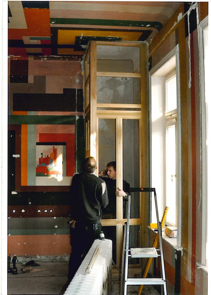
052 Rekonstruktionsarbeiten – Lastenaufzug (Tischlerei Hoobst)
