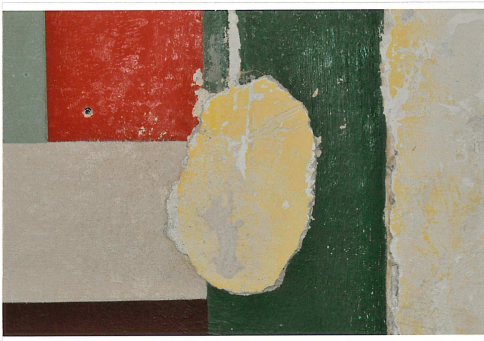
041 Zementputzergänzung vor der Behandlung
