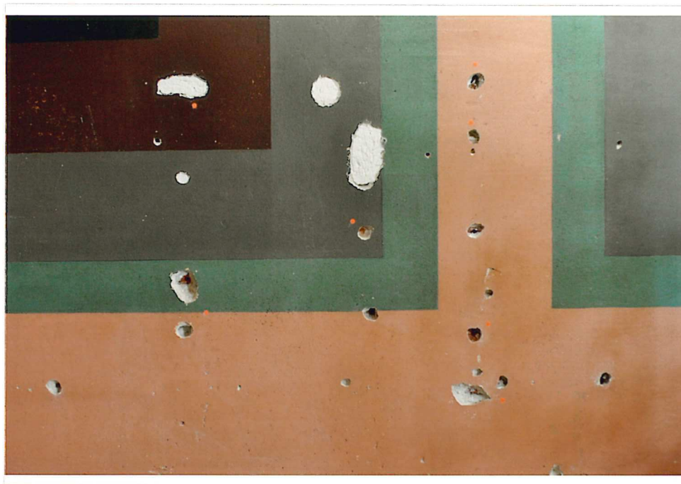
046 Detailaufnahme Nordwand – Zustand nach der Entnahme der Putzplomben
