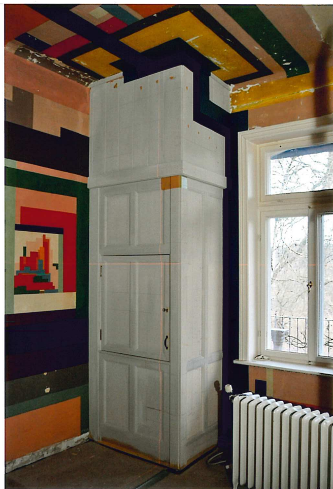
054 Farbrekonstruktion – Grundierung (Halbkreidegrund), erste Farbgestaltungen mit Ölfarbe
