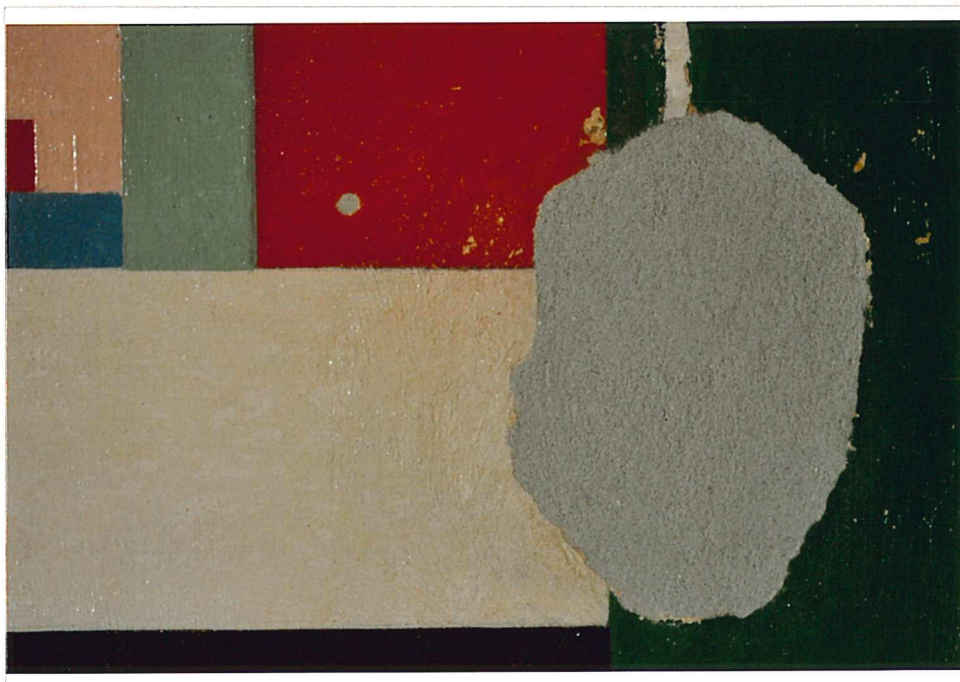
043 Putzergänzung mit Kalkmörtel fein, abgezogen auf Oberflächenniveau
