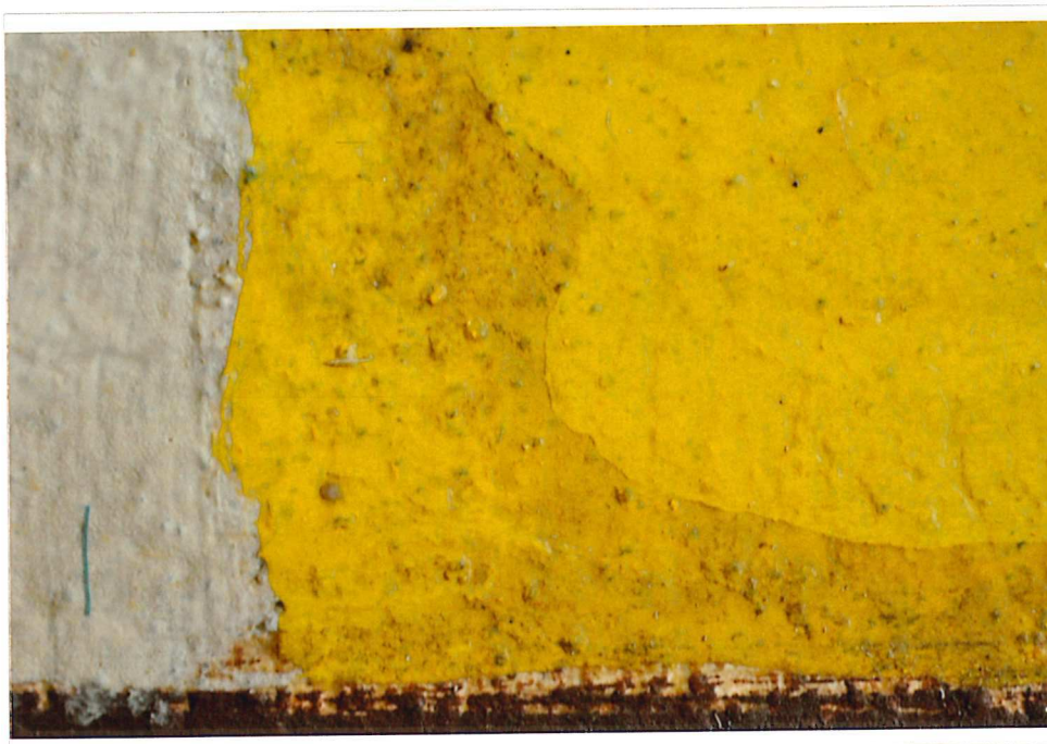
031 Detailaufnahme – zweischichtige Gelbfassung
